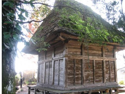
北面茅葺き屋根の損傷状況
